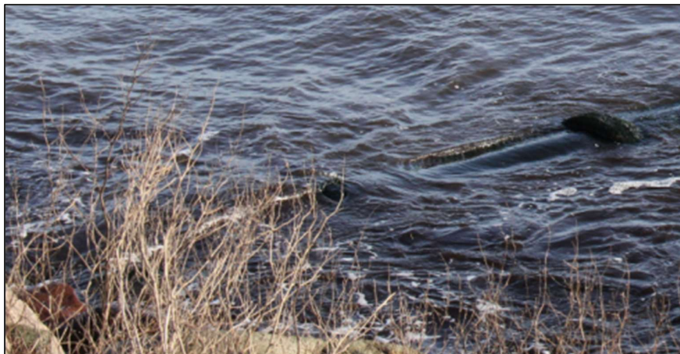
Figur 7: Ø600 mm udløb fra pumpestation.
